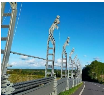
網走へ向かう道中、奥部町付近で見かけた道路への雪崩防止シャッター。雪国ならではの光景
