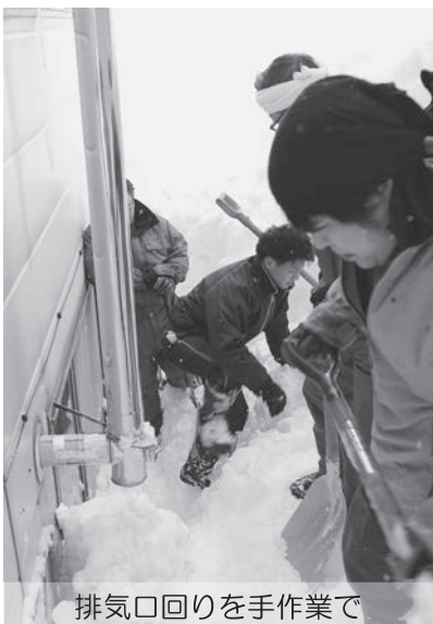
建設業協会による排雪の様子
