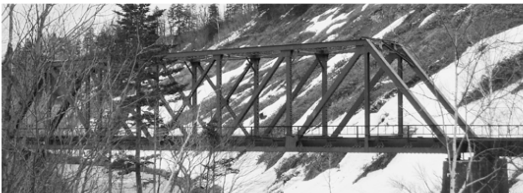
「第三雨竜川橋梁」
